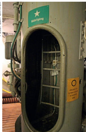
”Stjälken” med nödutgång i hissrummet. Granathissen på andra sidan.
