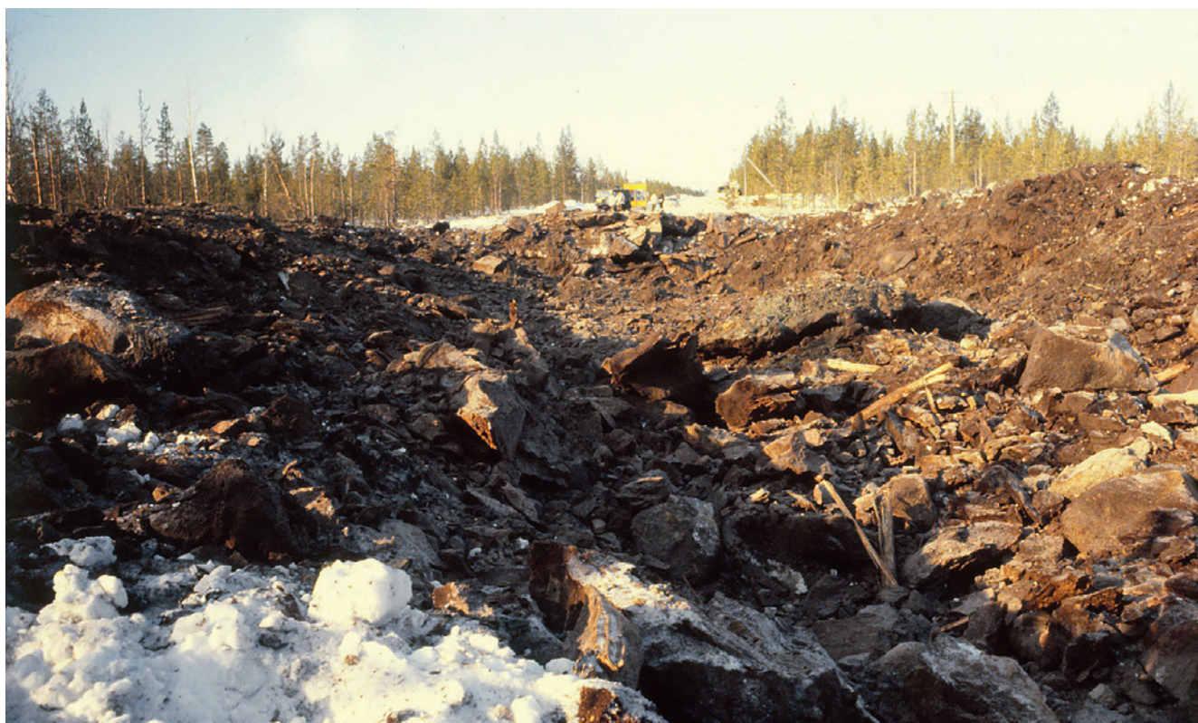
Vägsprängningsbild , vägbankssprängningar förbereddes främst på vägvagnsritt där vägen var omgiven av myrmark. Sprängplatsen kompletterades med minering av omgivande kringgångsstråk där även platser med fyllnadsmateriel minerades.
