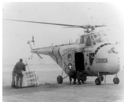
En räddningshelikopter har just hämtat upp en kamerabehållare ur vattnet. Markpersonalen håller i teleskopmasten med krok som vinschen häktat tag i. Foto: Paul Lovrencic
