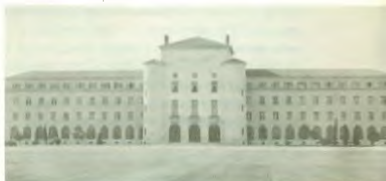
Ovan: Huvudbyggnaden vid Ecole de l'Air.
