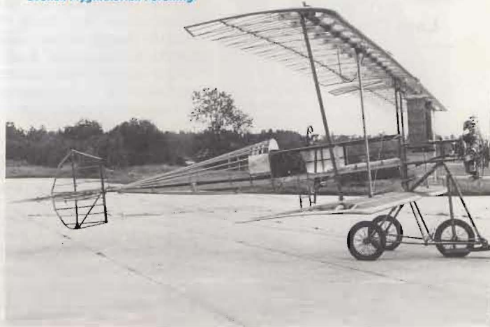
Breguet B 1 (det första av staten anskaffade militärflygplanet, 1912) provmonterad utanför en hangar på Barkaby (gamla F8) i augusti 1985. Motor, kylare och stjärtparti är originaldelar, övrigt nyttillverkat. Falltank, oljetank och främre sits ännu ej monterade. Fullskalerepliken byggs av medlemmar i Svensk Flyghistorisk Förening.
