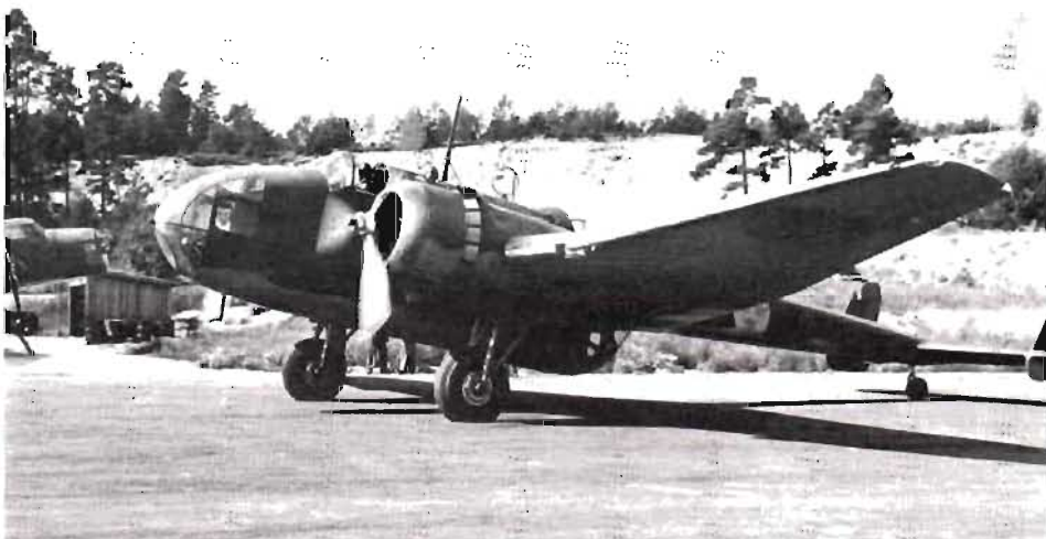
SAAB B 18 A — medeltungt svenskbyggt bombplan med två svenskbyggda 14-cylindriga dubbelstjärnmotorer typ SFA Twin Wasp STW C 3. Vapen: tre 13,2 mm akan, bomblast ca 1 ton. Planets toppfart ca 465 km/tim.
