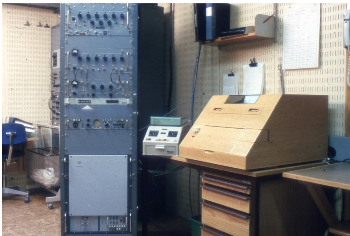
132. Kustradiostation mottagardel. Stab-stabsradio med ARQ
