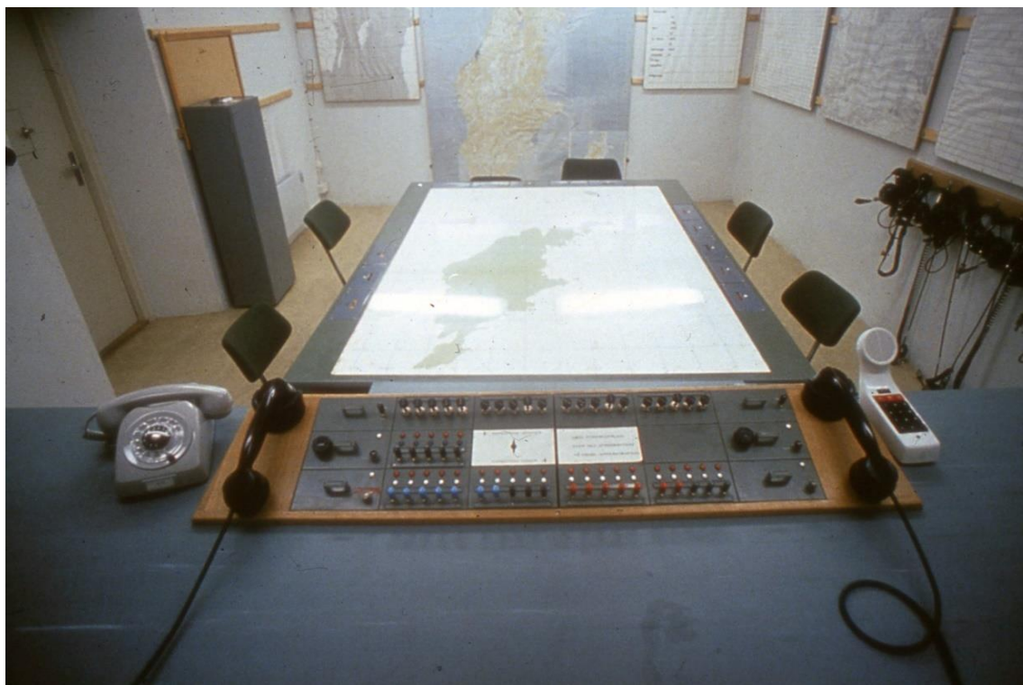
101. Stridsledningscentral. Slc utrustad med order- rapportkopplare m/51
