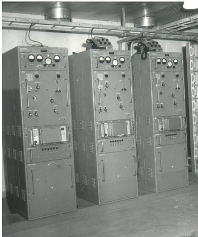
132. 1,5 kW KV-sändare m/54 för kustradioannex
