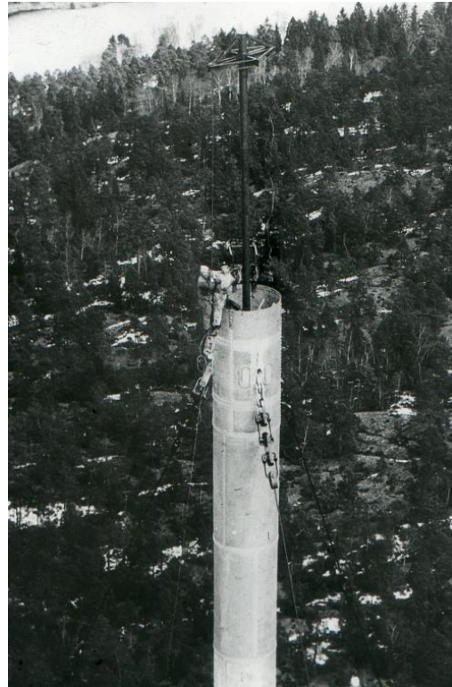
301. Ruda radiomast med montörer i toppen
