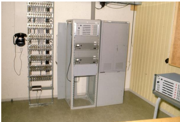
420. RoRa. I stativ omkopplingsenhet. Därutöver 2 st antennförstärkare (Roswa)
