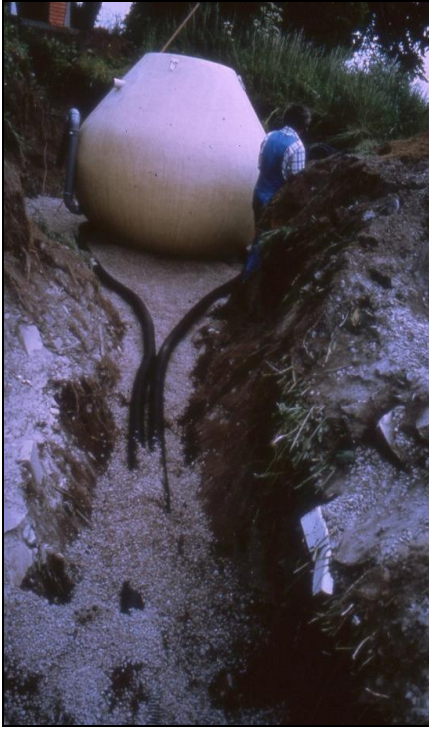
518. Radioannex i kula. Placering i schakt
