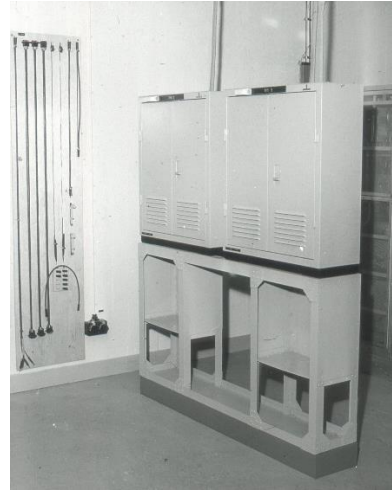
139 Siemens tonkanal- utrustning för fjärrmanöver av sändarannex (över tråd, reserv radiolänk)
