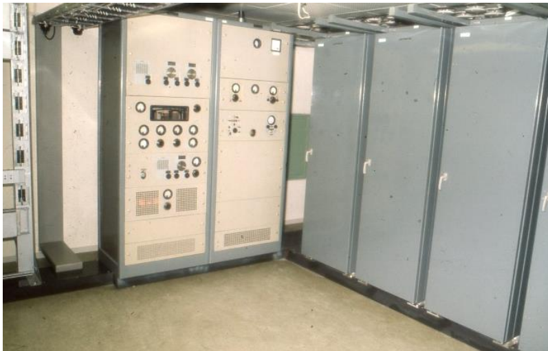
418. RoRa, sändarrum KV. 1 st 3 kW LV-sändare m/44-51. 4 st KV-sändare CT 1000.
