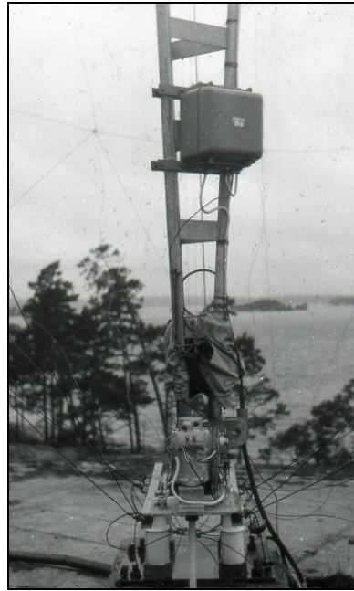
448. Fackverksmast med bredbandstrafo för anslutning av ryssjantenn.
