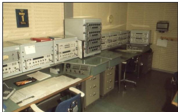
437. HfjRa. Expeditionsplats B och högra delen av A. Har KV-mottagare och manöverutrustning för sändare
