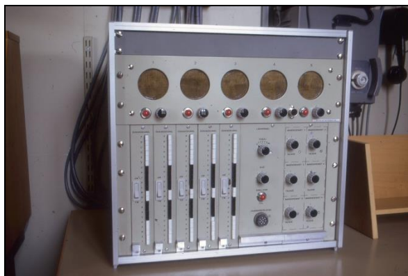
606. Troligen omkopplingsutrustning för manöver UK-station. För signalskolor
