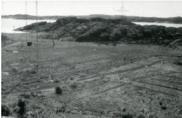
114. Älvsborgs Radios sändar-annex, långvåg till vänster, kortvåg (ryssantenn) till höger.
