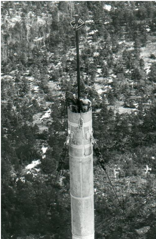
250. Ruda radiomast med montörer i toppen
