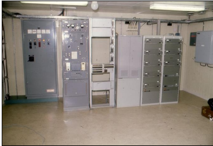
429. RoRa. Apparatrum Tele med bl a 1,5 kW KV-sändare m/54 som reserv.
