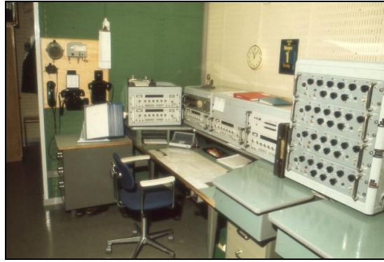
434. HfjRa Exp.plats A. KV-mottagare och manöverutrustning mot sändare.
