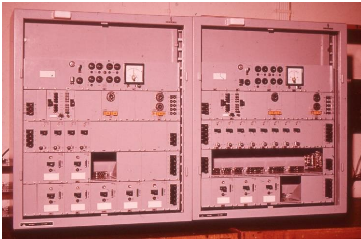
219. Tonkanalutrustning TKU för fjärrmanöver över tråd eller radiolänk (Siemens).
