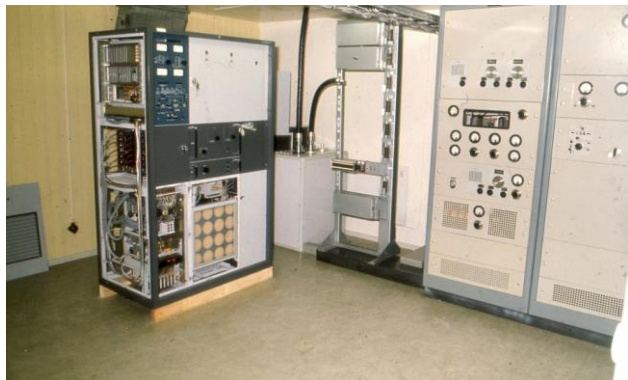
414. RoRa. 10 kW Philips sändare (t.v.), 3 kW LV-sändare (t.h.)
