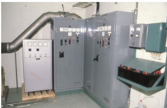
415. RoRa. Elkrafttrum med batteribackup.
