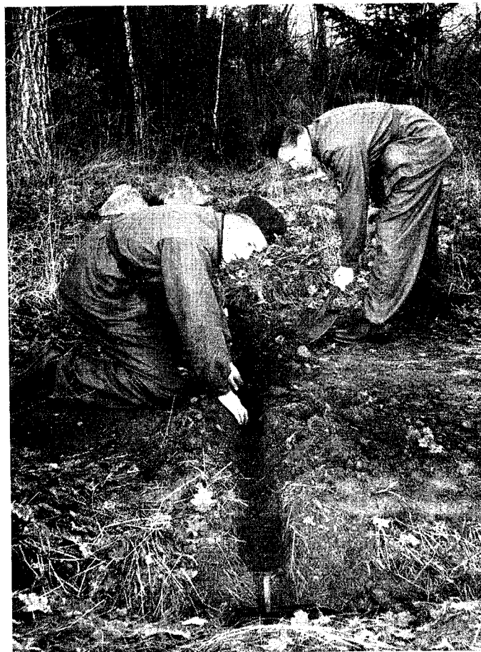
Bild 17. Korsning av väg i kabelränna
