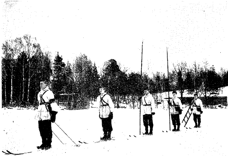
Bild 24. Färdiga till linjebyggnad
