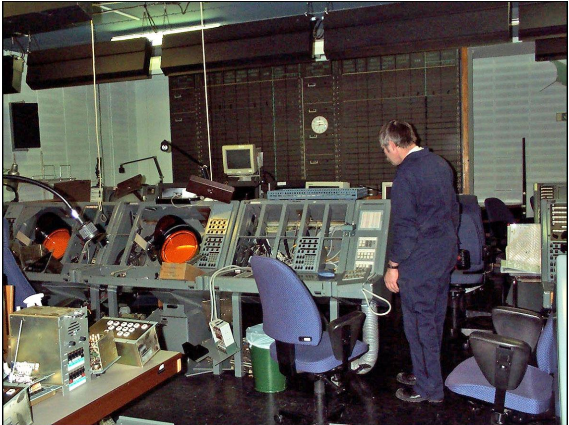
Demontering av Tråjal-plats.
