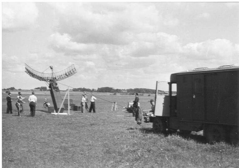
Bild 11. PS-41/T reses på Arbogafältet med hjälp av en bil.
