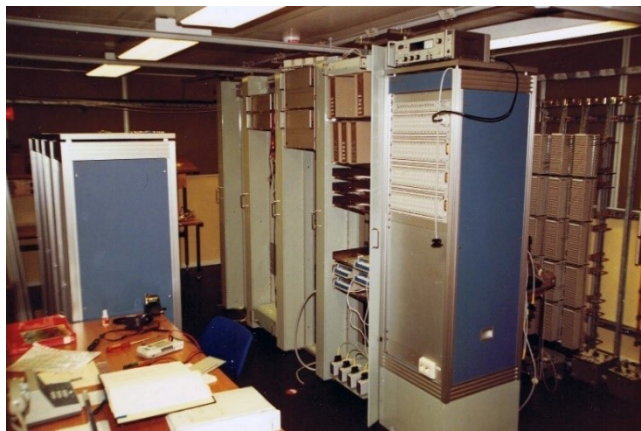
MFC V dator- och transmissionsrum. Till vänster Norsk Datas N-100 kabinett med device-switch i mitten. Till höger Siemens patch-stativ och telegraföverdrag. Korskopplingsstativ längst till höger.
