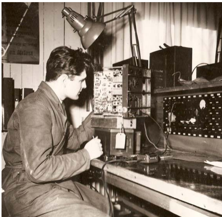
Ännu en elev vid FCU var furir Curt Norell. Han blev senare avdelningsdirektör vid FMV. Här reparerar han en Ra 120.
