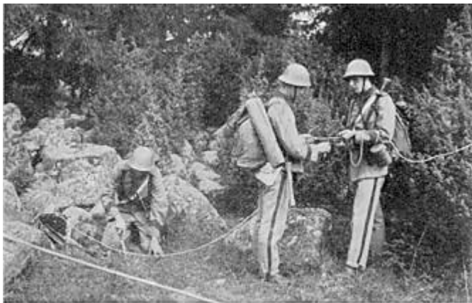
Rullbyte vid linjebyggnad med lacktråd.
