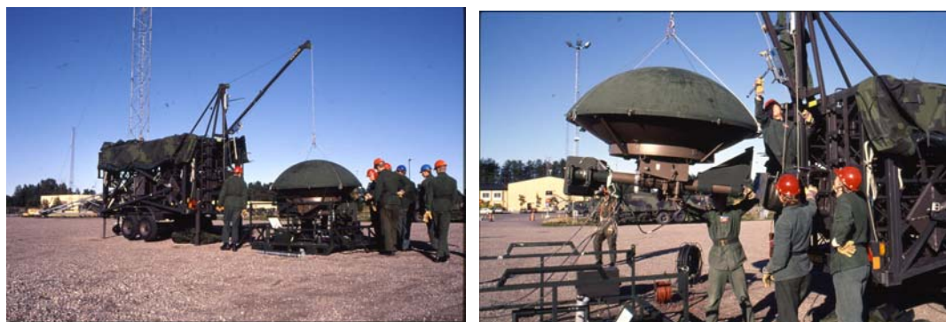
Bild 151 Montage av antenn till mast 35 m
