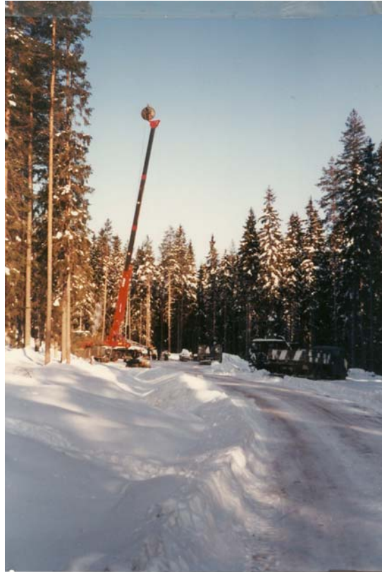
Bild 138 Försök med antenn i mobilkran
