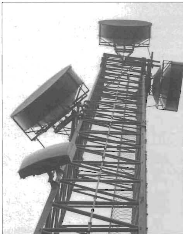
Parabolantennerna med "krage" för RL-81
