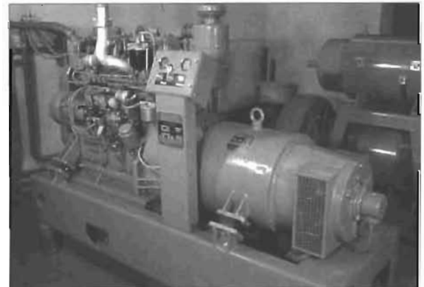
Reservkraftaggregat
