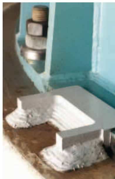
DFS:en kräver rejäla förankringar i det 450 ton tunga betongfundamentet.
