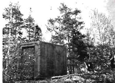
● Helikoptern används till jobb av alla de slag. Här flyttas ett hus. ◇ Nedan t v: Helikoptern är oundgänglig tack vare sin förmåga att kunna ta sig ned på de mest otillgängliga platser. Här på en liten kobbe i havsbandet.
