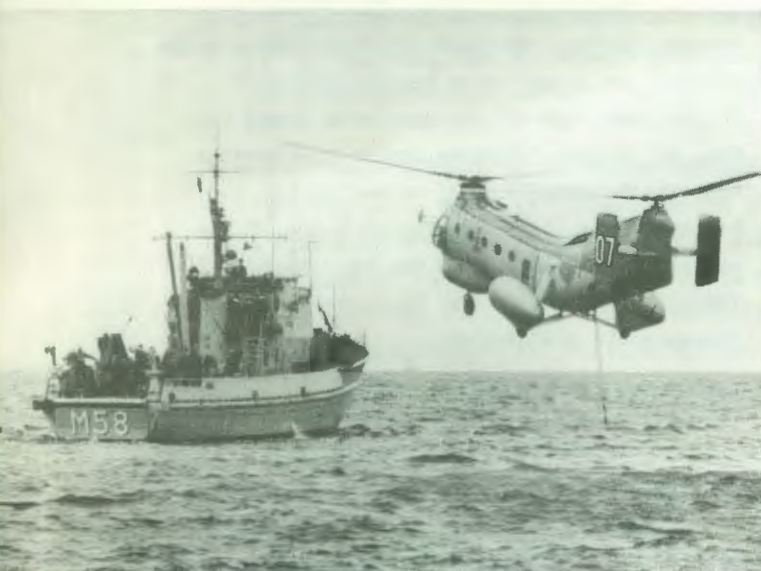
Ovan: Minsvepning med hjälp av helikopter. Nedan: Tecknarens syn på hur sjunkbombfällning kan ta sig ut med den nya Vertol 107.
