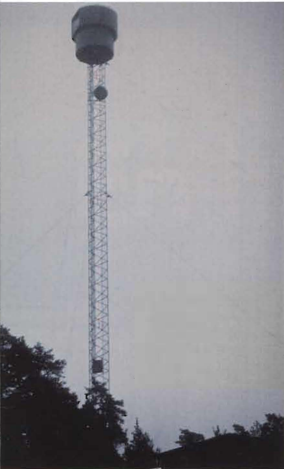
Radarstationen PS-15 har använts inom luftbevakningen för att spana efter lågt flygande flygplan och ytgående fartyg. Systemet togs nyligen ur drift.
