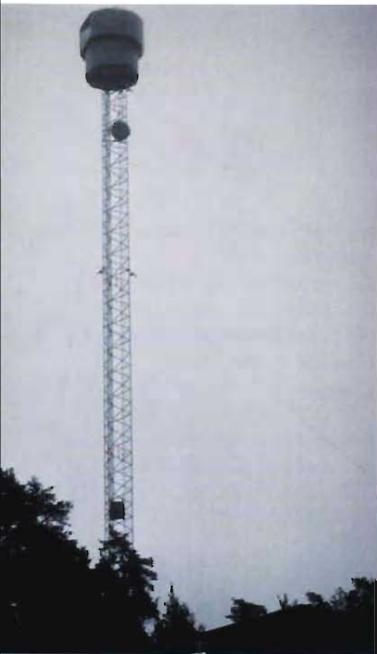
Radarstationen PS-15 har använts inom luftbevakningen för att spana efter lågt flygande flygplan och ytgående fartyg. Systemet togs nyligen ur drift. Foto: Försvarets bildbyrå
