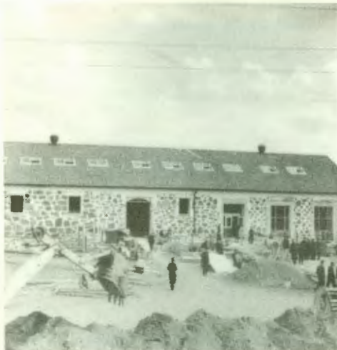
Lektionssals- och matsalsbyggnaden "Abboten" under ombyggnad. Tio lektionssalar göms under takfönstren.
