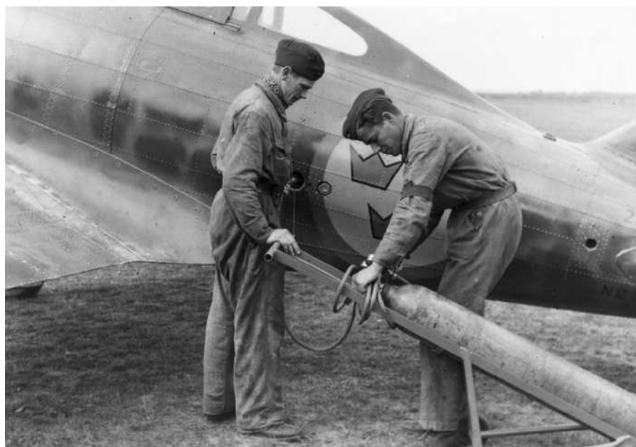
J 20 startades med tryckluft, som här fylls på flygplanets egen tryckluftstank.
