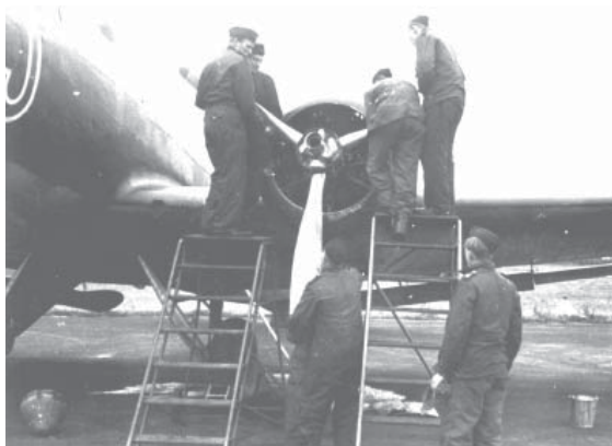
Byte av propelleraxel. Foto från Gunnar Lindahl
