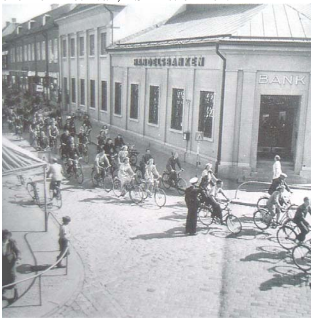
”ASEA-strömmen” på Stora gatan.
