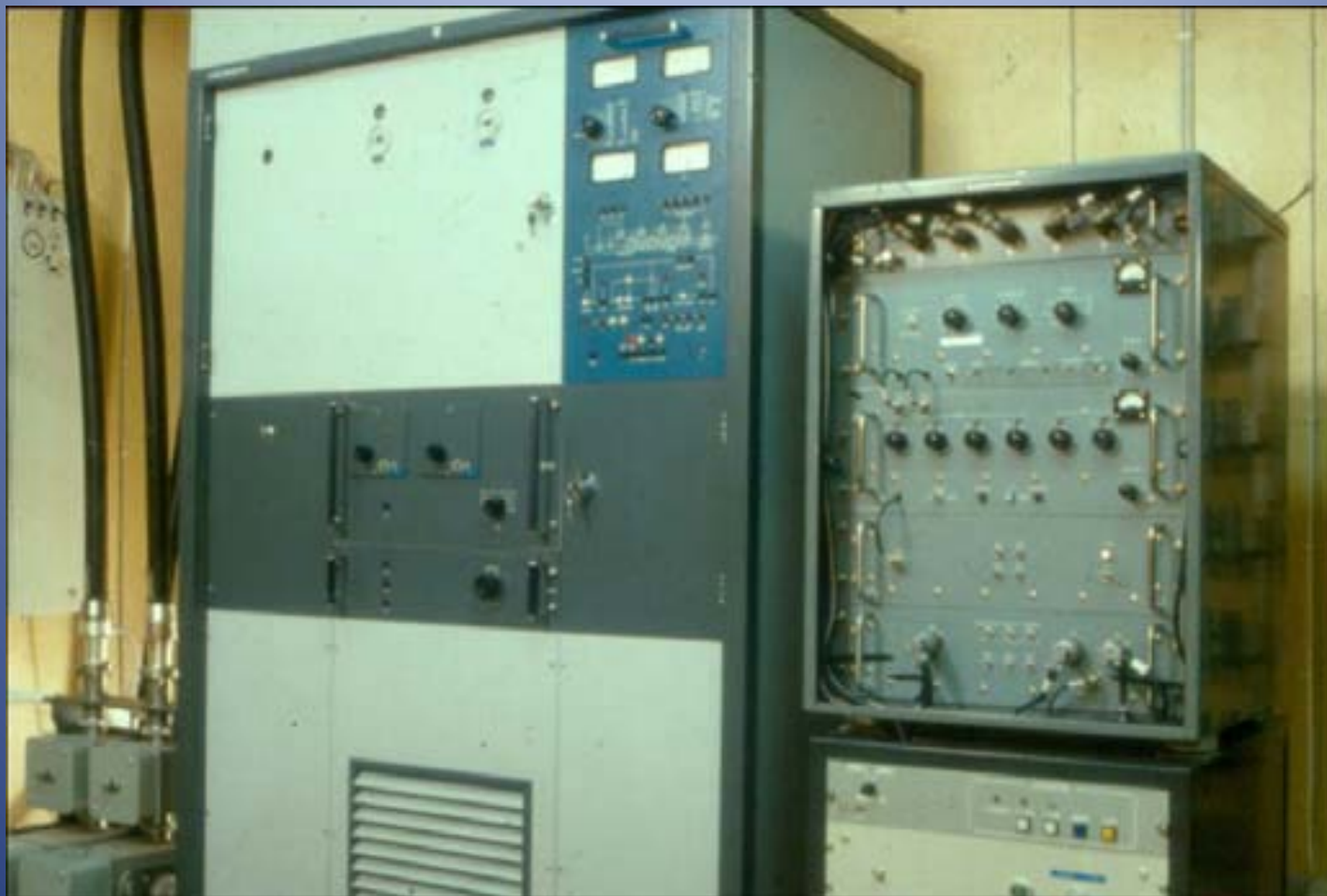
KV-sändare 771, 10 kW. Tillverkare Philips, drivsteget till höger från SRT
