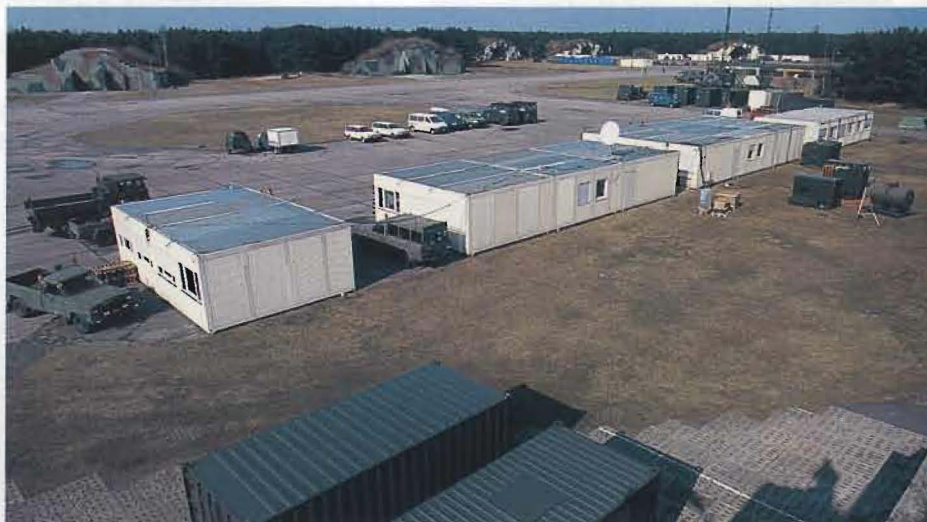
Den svenska stabsplatsen på Powidz-basen. Utöver egna containere användes inhyrda baracker.
