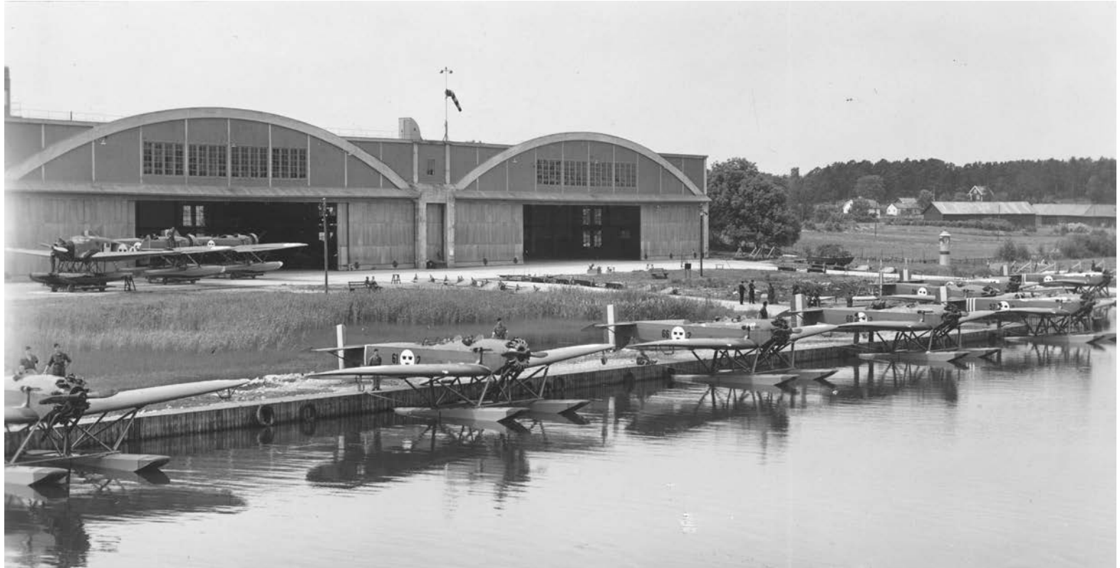
Hangar 81. Byggstart 1927. Samt S5 Hansor vid kajen.
