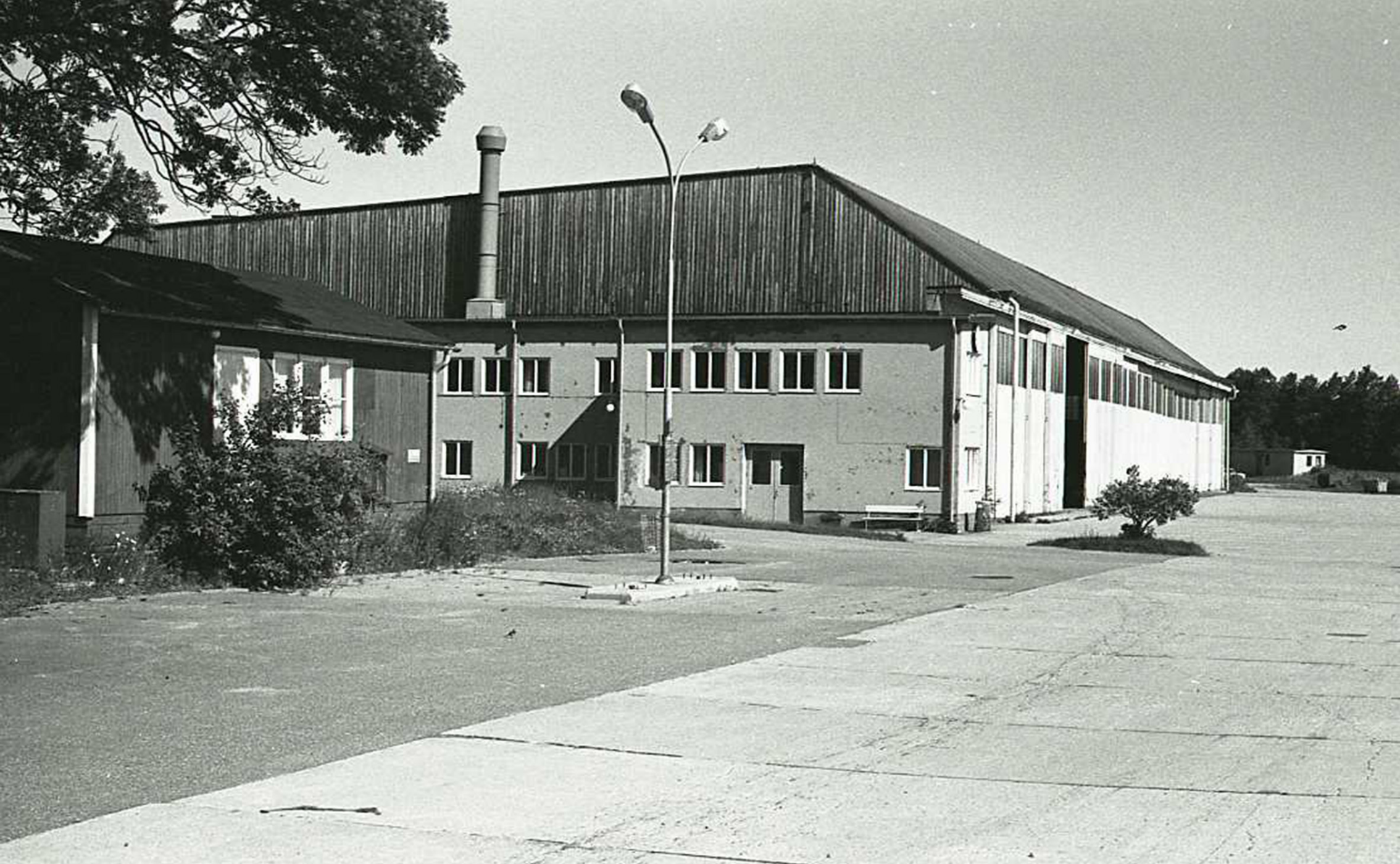
Bild 8. Hangar 82. Bensin station.
