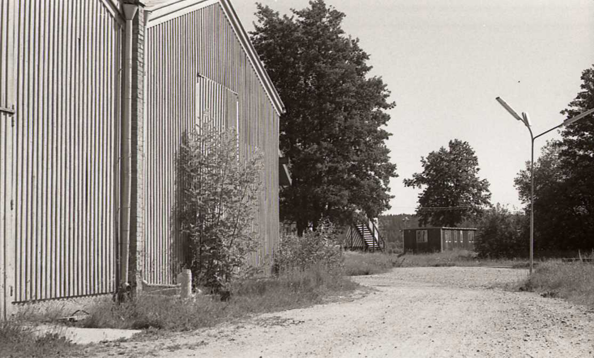
Bild 60. Gamla trähangarernas gavlar mot söder.
