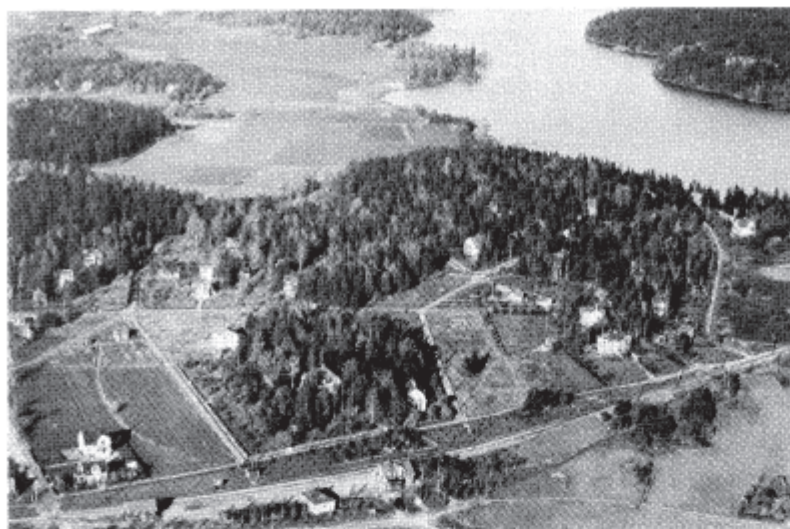
Norra Viggbyholm på 1930-talet. Järnvägsstationen i mitten av bildens underkant.
