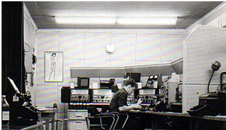
Vaxholm radio, expeditionsbaracken vid Rindö smedja. Telegrafisten på bilden är Olav Timlin (Larsson), bilden 1950-tal. Mottagarna av typen m/50, tillverkare: GE Typ BRT 400ES
