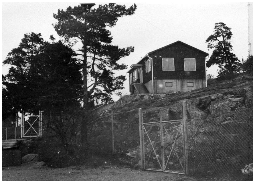
Rindö västra. Grindar till höger leder intill bergrummet och den skyddade expeditjonsplatsen. Baracken på hjässan innehöll såväl fredsexpeditionen som förläggning.
