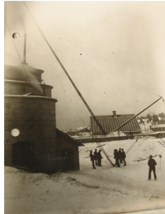
Bild från mastresningen 1914 i Vaxholm. Masten verkar vara av metall, hjälpmast användes. Stationshusets tak skymtar.
