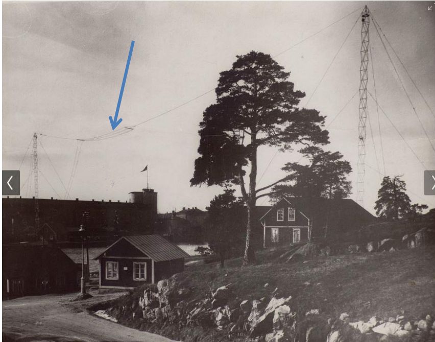
Vy från Rindö mot Kastellet. Notera de två 50 m Rendablmasterna med trådantenn och nedledning. Foto: Tekniska museet
