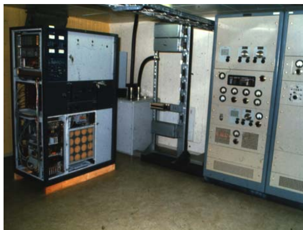
Roslagen Radio, sändare 10 kW, antennväxel och LV-sändare 3 kW.
