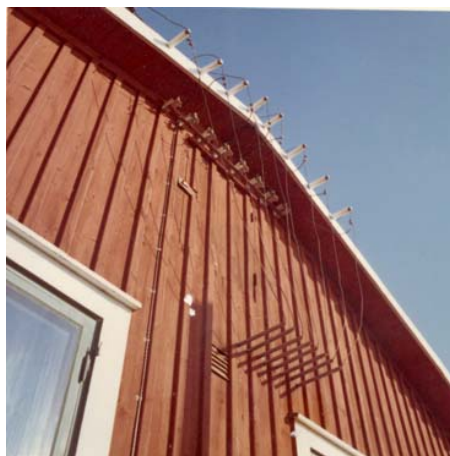
Detalj antenngenomföringar.
