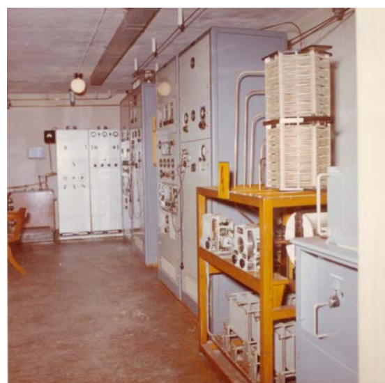
Apparatrum , sändare 800 o 3 kW.
