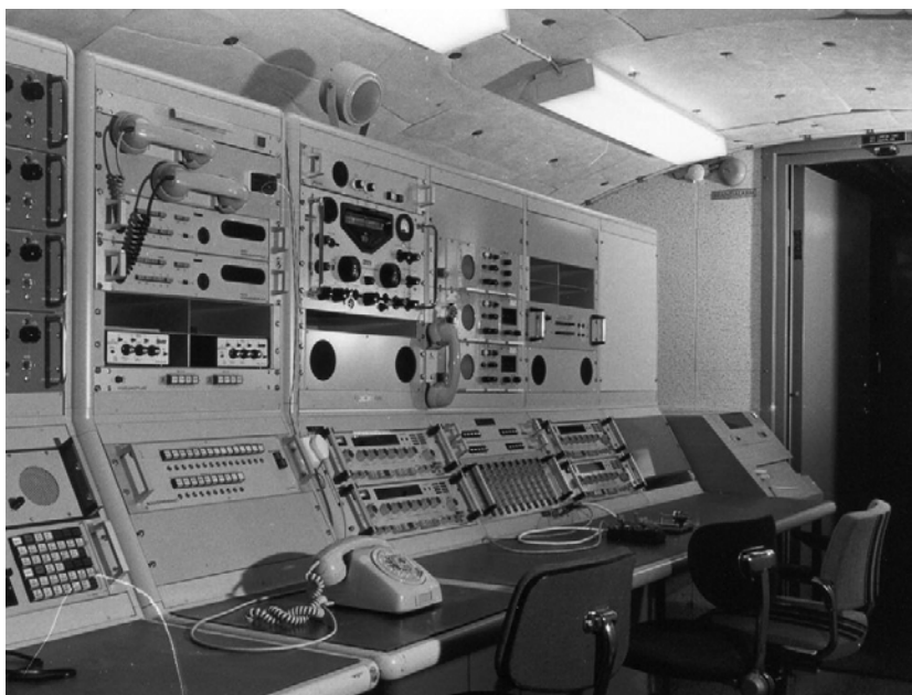
ÅngRa. Mottagarcentralen i början på 1980-talet.
