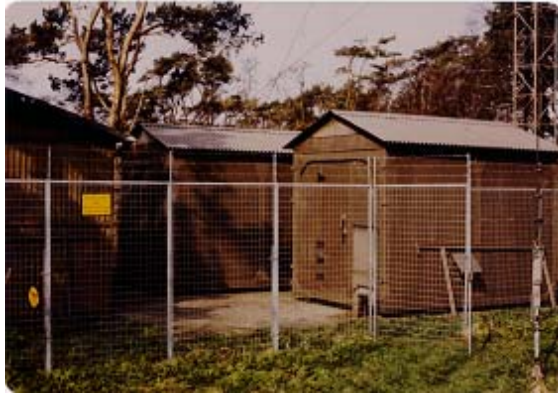
Bild 23 Spaningsplats med stationshyddor och förråd
