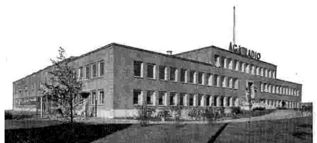
AGA:s Gävlefabrik (Foto AGA)
