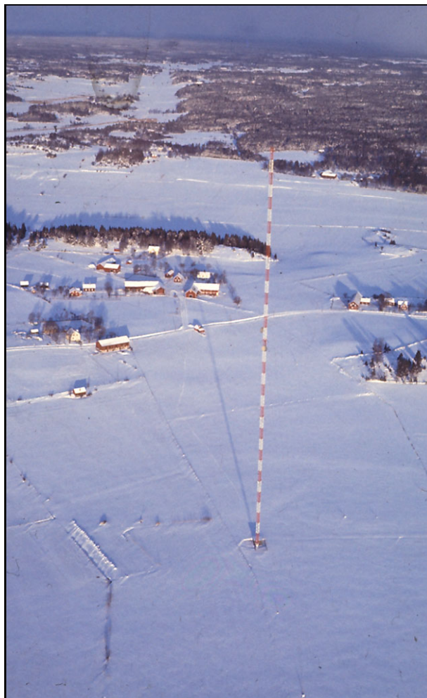
RT-02 antennmast vid Roslagsbro.
