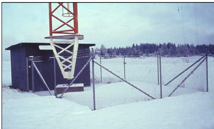
Antennmastfoten med bunkern för antennavställningsstativet
