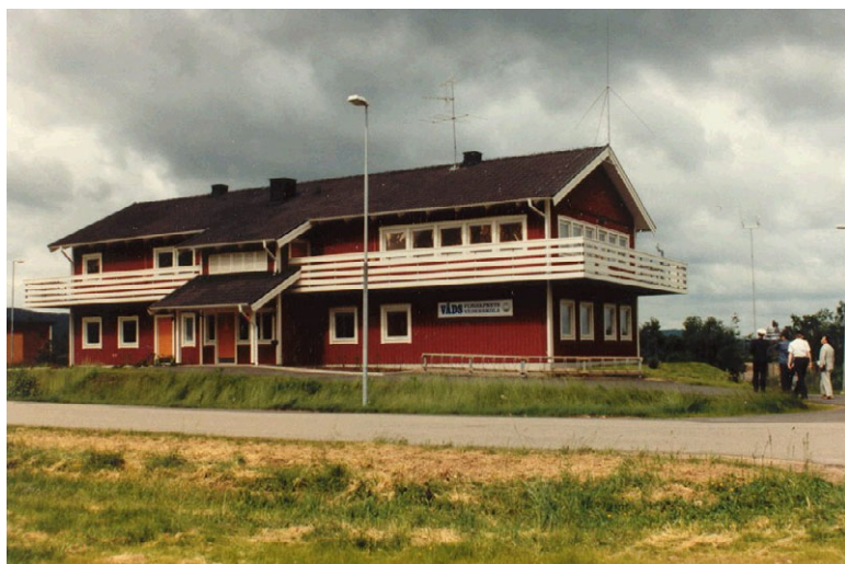
Väderskolans lektionsalsbyggnad vid F5 Ljungbyhed.
