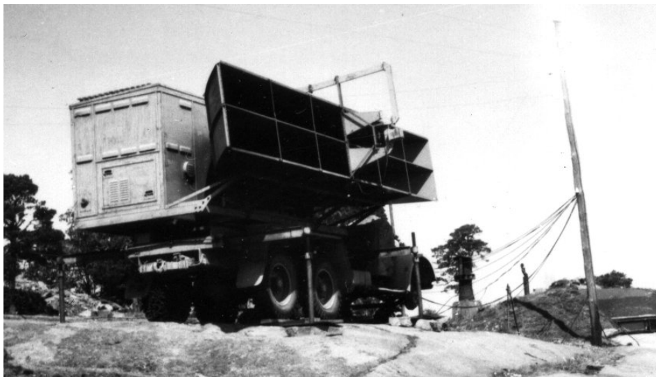
Bild 1. Ursprungsvarianten AMES-14 Lägg märke till den dubbla ostformade antennen.
