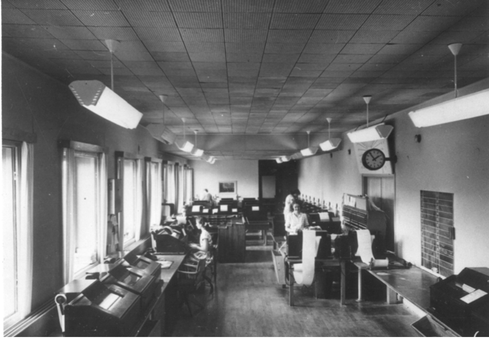
Flygvapnets teleprintercentral. Foto FHT
