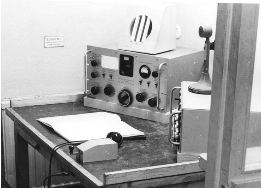
Reservbetjäningsplatsen i sändarstationen. Foto Flygvapenmuseum
