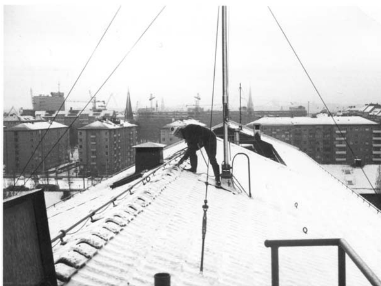
Ett arbetslag från CVA utför en antenninstallation för CFV-radio. Foto AEF
