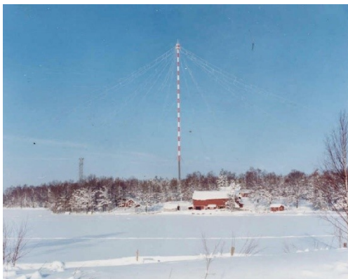
Ruda radio med nedisade paraplylinor (Julkort)
