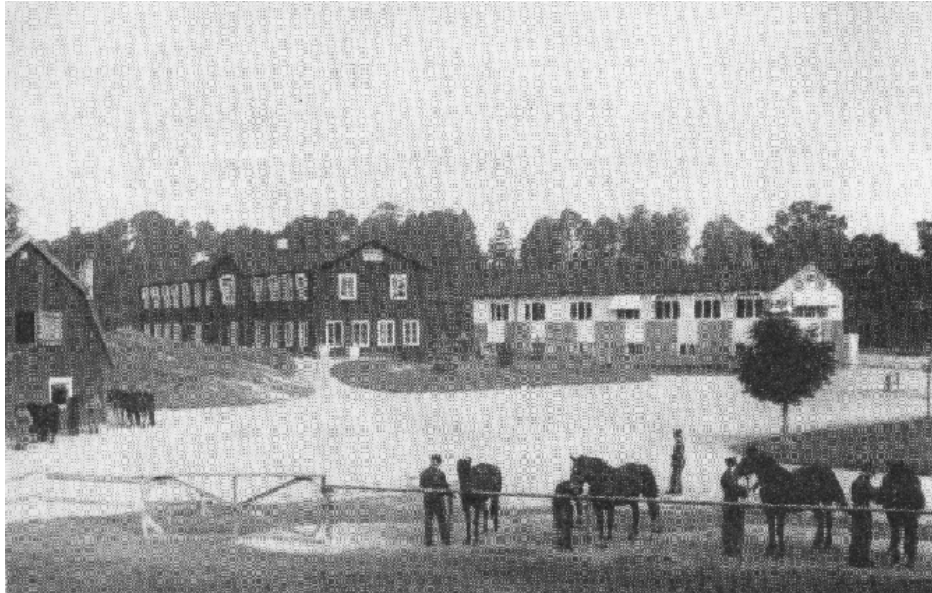
I den röda byggnaden i mitten låg elektriska verkstaden samt i det vita f d ballongförrådet elektriska laboratoriet.
