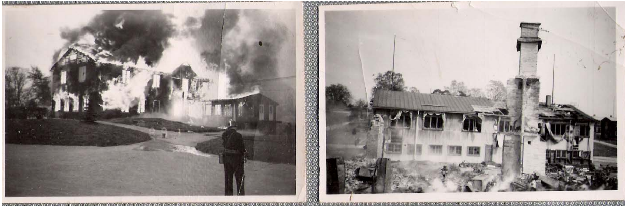
Branden av radiofabriken i maj 1939 då finska arméns alla 10 W brann upp. Sabotage misstänktes eftersom kriget kom den 30 november samma år.
